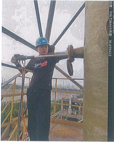
脱硫废液制酸排气筒 (DA062)
