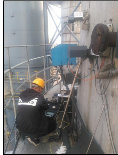
3#、4#焦炉处理设施后废气采样
